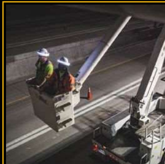
空港・滑走路作業 鉄道線路内作業など
