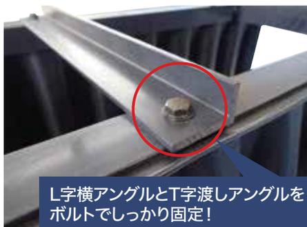
アングル補強が土圧による変形を防ぎます。
