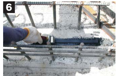
⑥ ハンドローラーで止水材の上表面を圧着してください。
