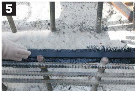
⑤ 接着塗布面上にネオспанシールを貼り合わせます。
