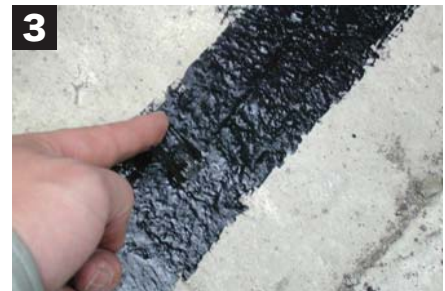
③ 接着剤は塗布後指でふれて粘着しない程度(塗布後10分以上)まで乾燥させた後、次の作業を行ってください。
