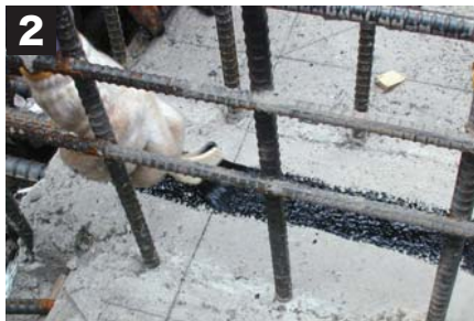
② 接着剤PB-50を30mm巾以上ハケで塗布してください。 (注) 接着剤PB-50は、蓋を開けたままにすると粘度が上昇しハケ塗りが困難になりますので、こまめに蓋を開けてください。
