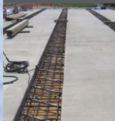
コンクリート打設前
