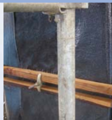
角材を用いて固定
