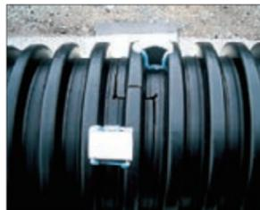
4 シーリング材を巻き、重ね合せ部にテープで止めます。次にソケットをかぶせ、15～20N・mトルクまで締めこんで作業終了です。
