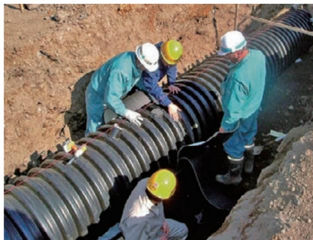
トヨドレンダブル管(JH型)は高速自動車道の大口径雨水排水管として開発され、リング管と同様、高い水密性を備えています。
