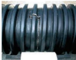
3 シーリング材Aを右図のように、管端より1山目の谷部に設置してテープで固定し、コーキングパテを貼付けます。コーキングパテを入念に伸ばすように押さえ付け、管とシーリング材Aの隙間を無くすようにします。
