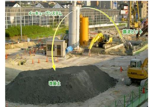
安定処理土は、まだ液性状態であるため、ハンドリング性を改善するには大量の固化材（セメント、石灰など）が必要とします。そのため、ダンプトラックで運搬するためには、広大な改良土の養生場所と日数が必要となります。
