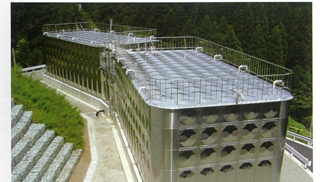
■容量/525m 3 ×2基 寸法/7m×15m×5m H×2基
