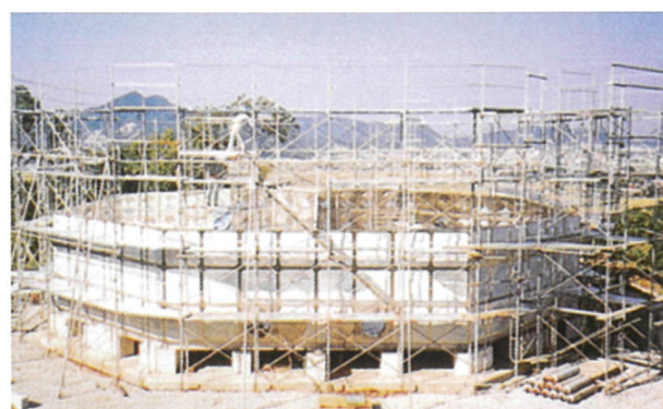
05 側板組立 側板下3段の溶接組立を完了する。
