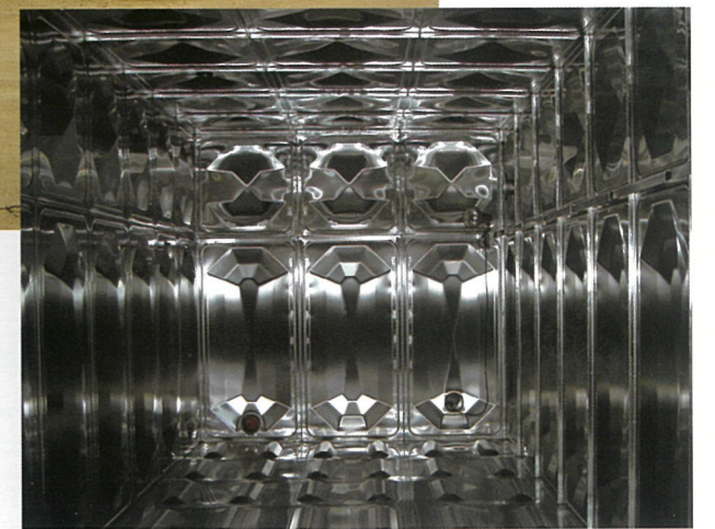
■外部補強タンク(ポンプ室付)内部
