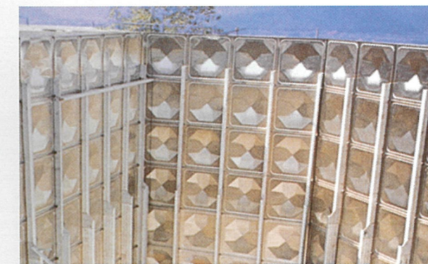
07 内部側面フレーム組立 側板内部の溶接に沿って、縦フレームを溶接組付する。
