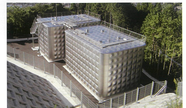
■容量/945m 3 ×2基 寸法/9m×14m×8m H×2基
