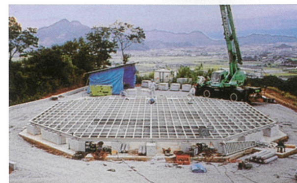
02 受台組立 鋼材で作った受台を、基礎の上に基盤状に設置し、アンカーボルトに固定する。
