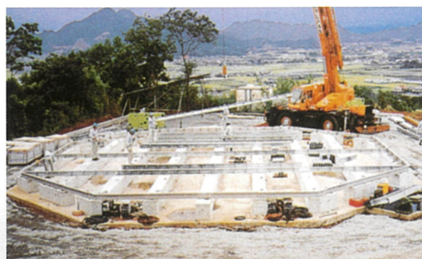
01 基礎の施工 基礎を施工する。
