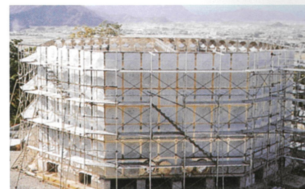
06 側板組立完了 側板最上段の溶接組立が完了。内部工事に移る。
