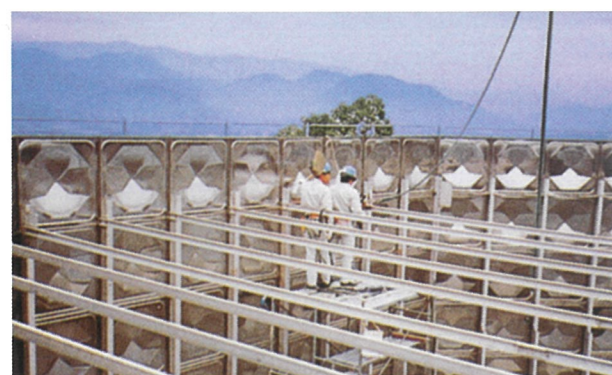
08 内部梁フレーム組立 次に梁材を順次溶接組付し、フレーム構造を仕上げる。
