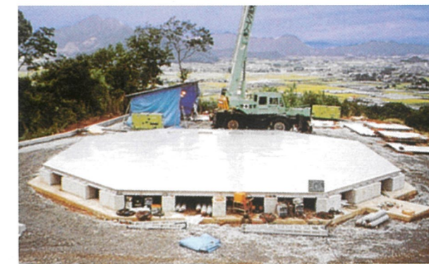
03 底板組立 受台の上に底板を並べ、溶接する。
