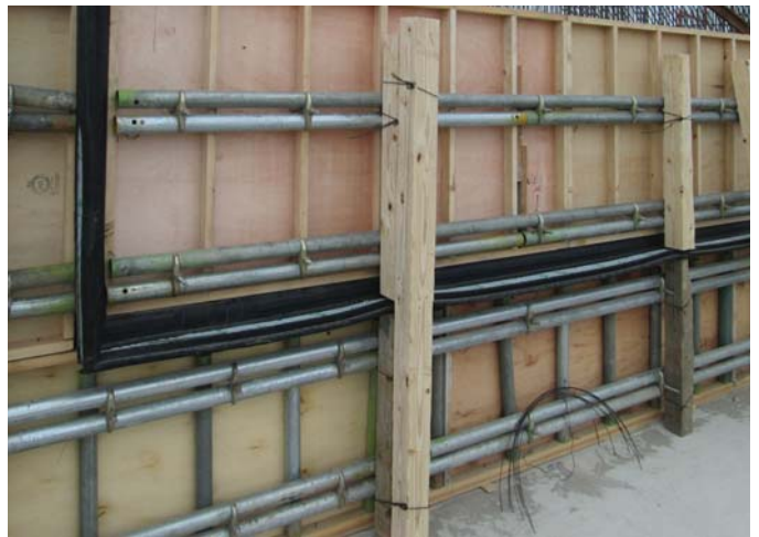
⑥ 型枠設置完了(コーナー部)
