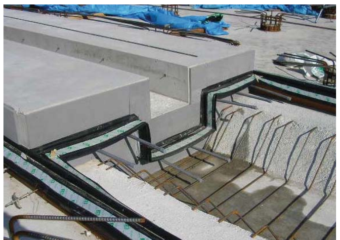
⑧ 先行型枠脱型完了
