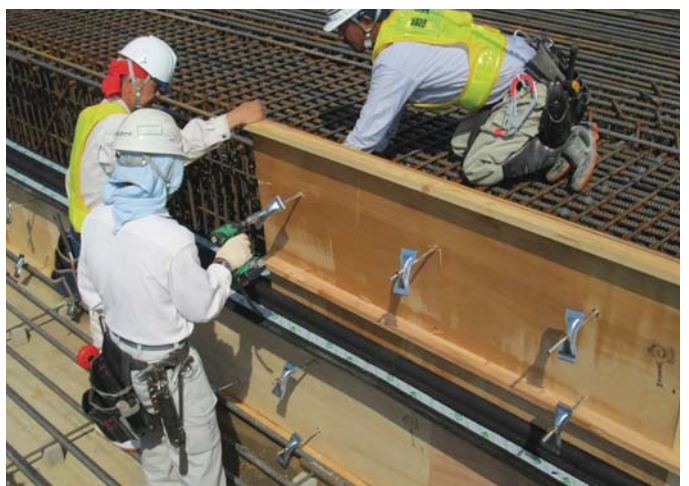
④ 型枠設置状況
