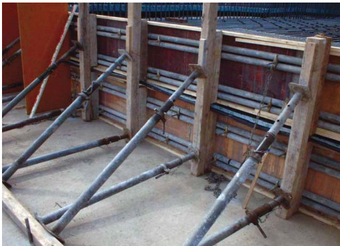
⑤ 型枠設置完了
