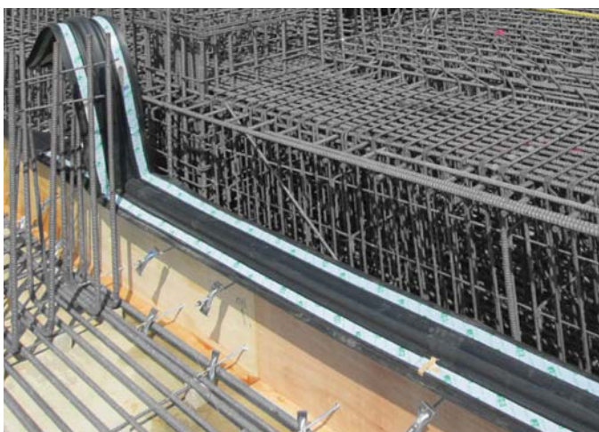
③ 止水板設置状況
