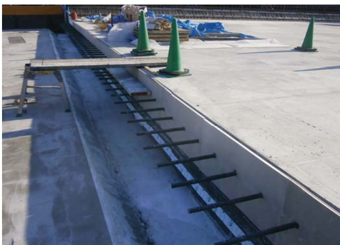
⑦ 先行型枠脱型完了
