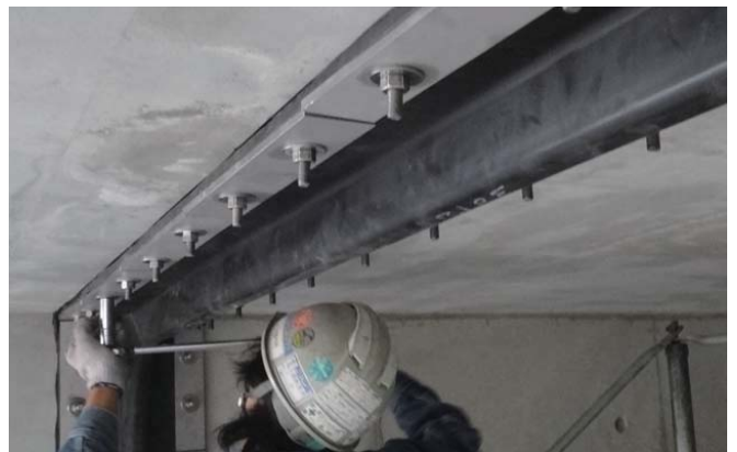
押さえ板取付状況
