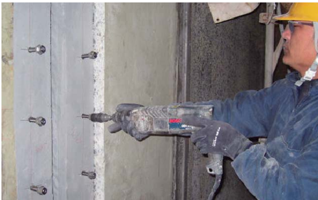
アンカー打ち込み状況
