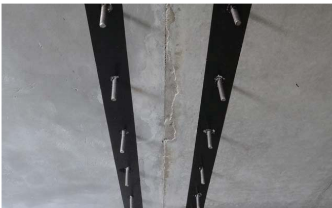
サンタックボンドPB-50塗布状況
