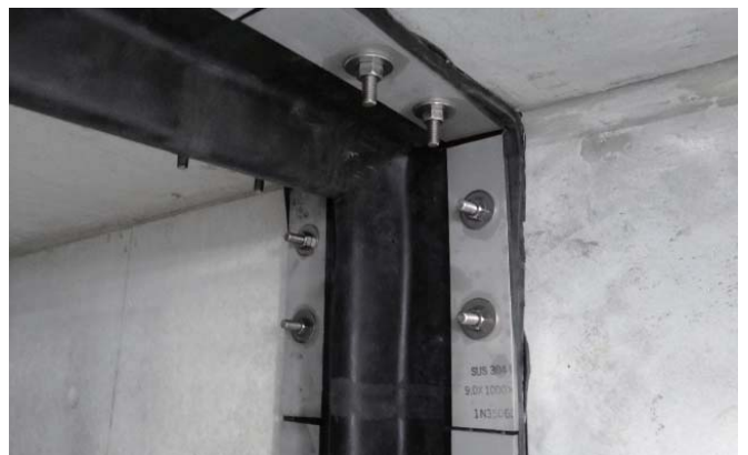
仕上がり状況
