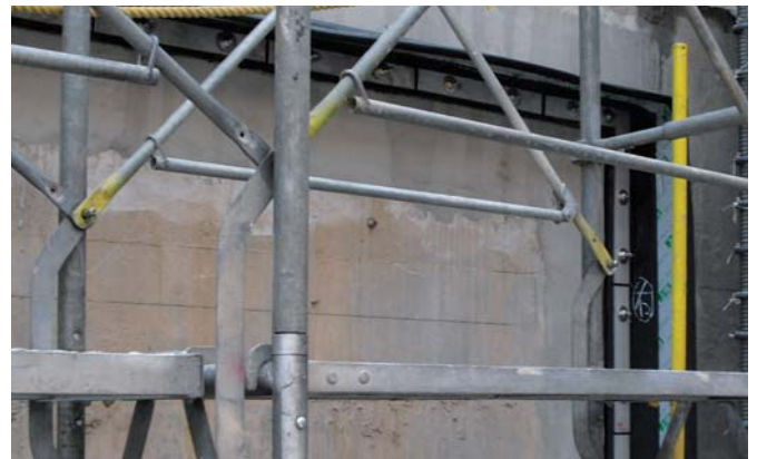
仕上がり状況
