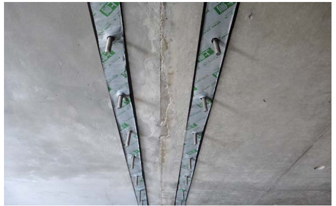
シール材貼付け状況
