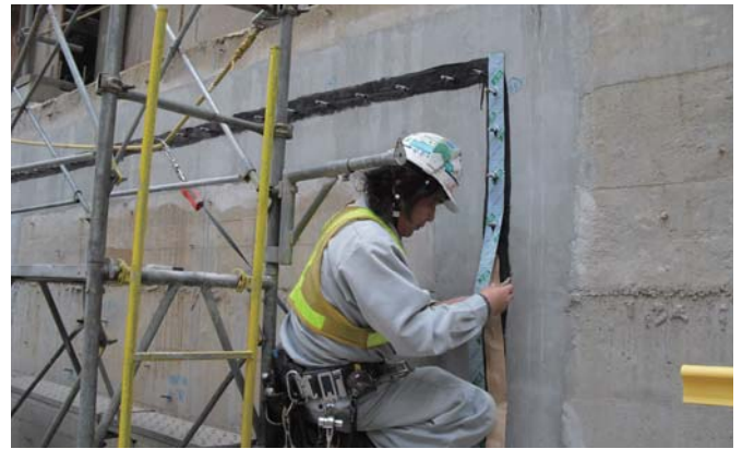
シール材貼付け状況
