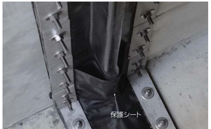
保護シート 保護シート取付状況
