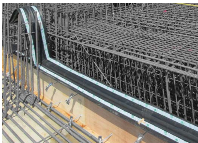
③止水板設置状況
