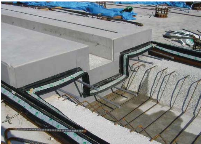
⑧先行型枠脱型完了
