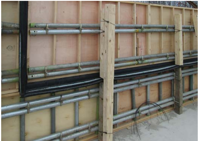
⑥型枠設置完了(コーナー部)
