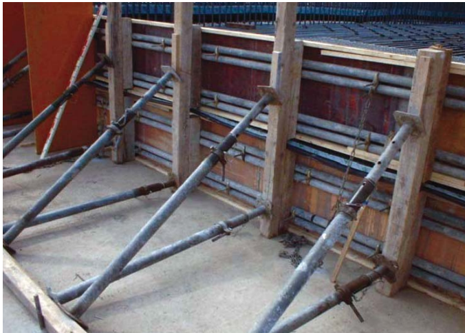
⑤型枠設置完了
