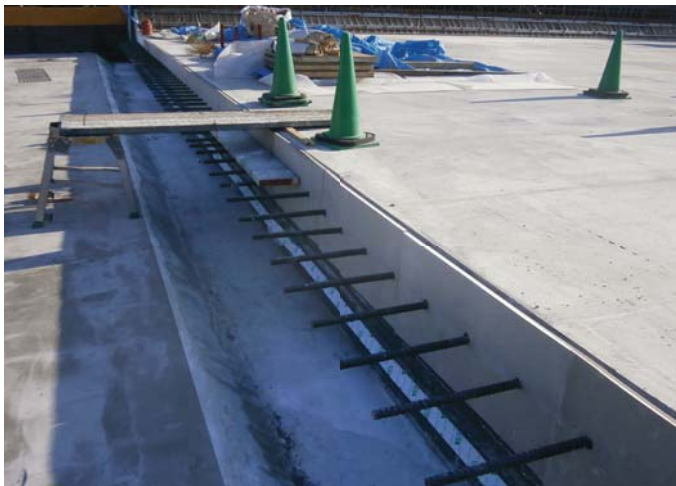
⑦先行型枠脱型完了
