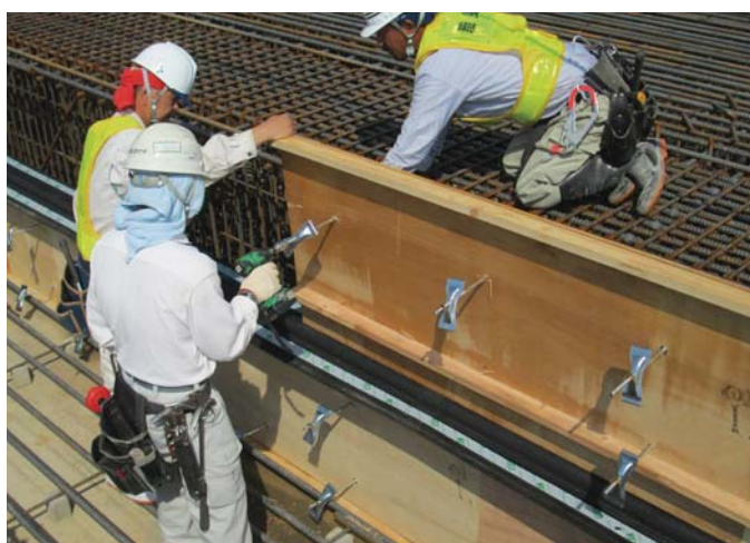
④型枠設置状況
