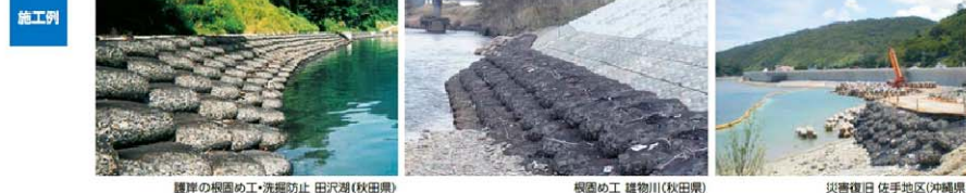
護岸の根固め工・洗掘防止 田沢湖(秋田県) 根固め工 雄物川(秋田県) 災害復旧 佐手地区(沖縄県)
