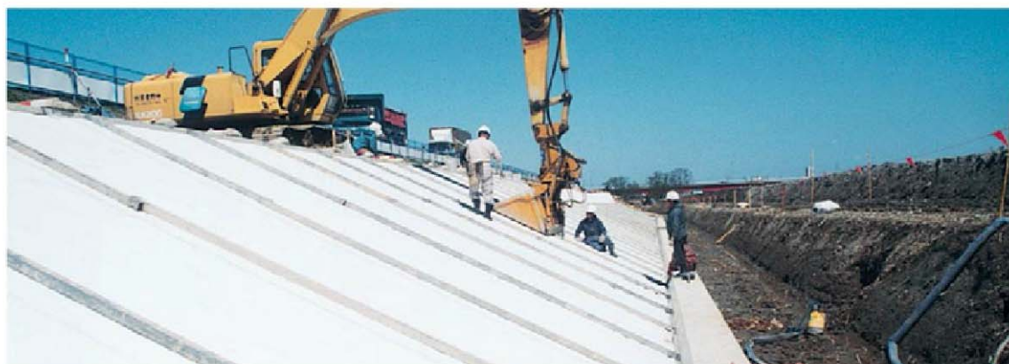
河川・堤防などの、のり面遮水工
