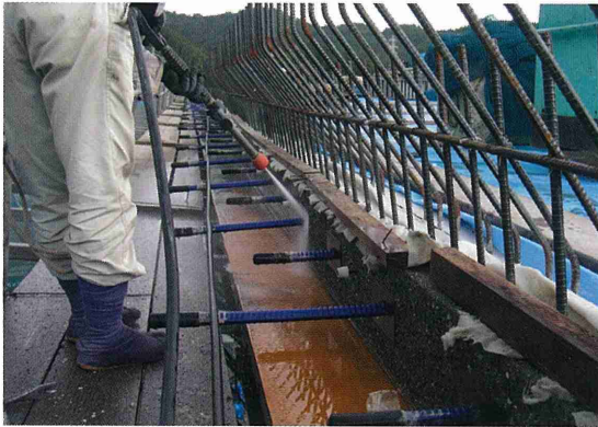
土木：橋梁での水洗出し作業中
