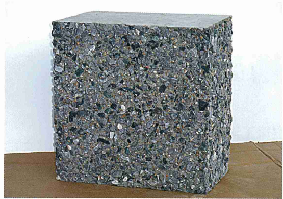
土木：打ち継ぎ面処理
