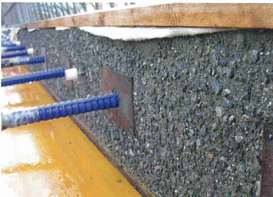
土木：洗出し後の打ち継ぎ面
