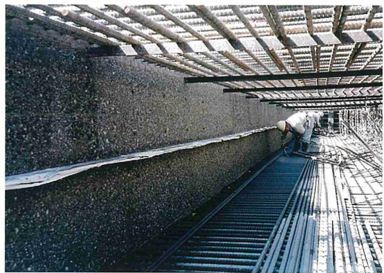
土木：浄水場での使用例
