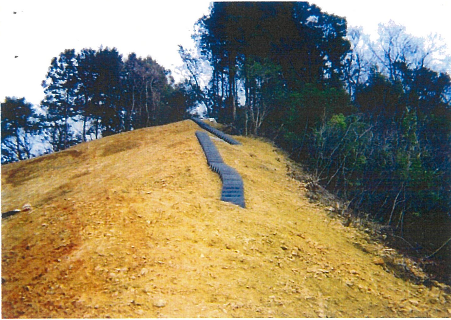
土面施工 (切土)
