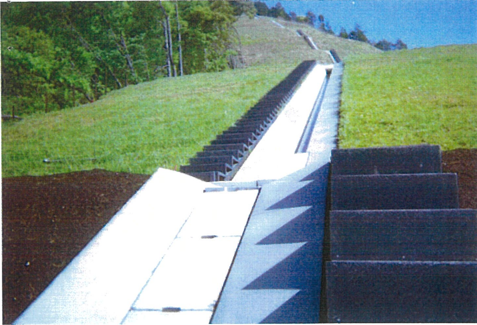
平滑で柔らかい地面 (盛土面) 取付
