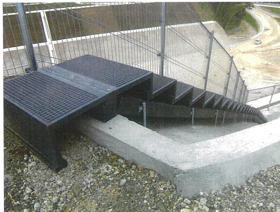
シールコンクリート面 取付
