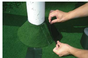
<タイピングシート使用例> (ガードパイプなどの周囲)
