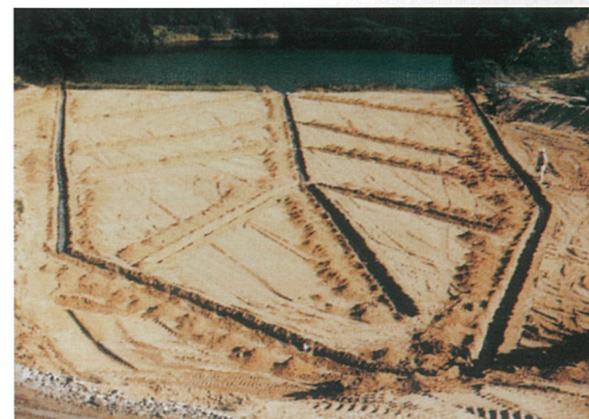
盛土下部暗渠排水
