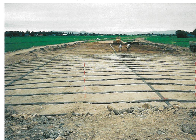
軟弱地盤の圧密水の排水
