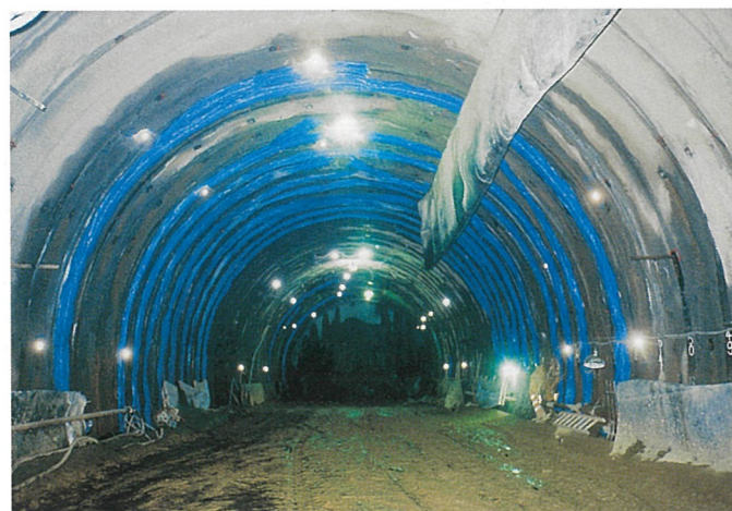
トンネル裏込排水
