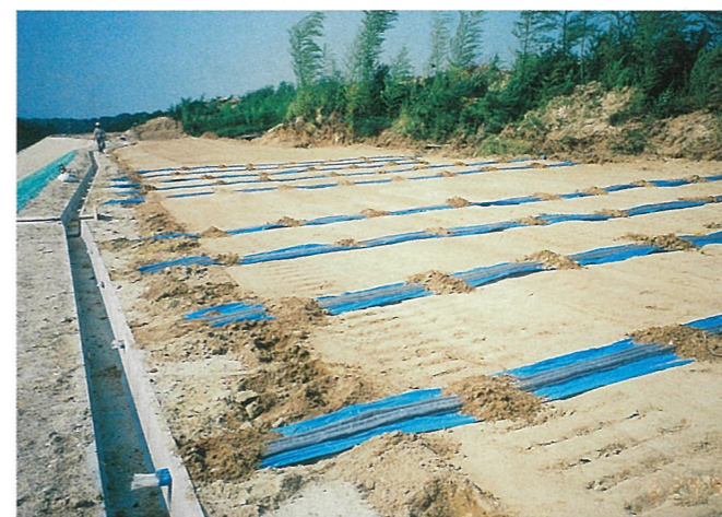
盛土内水平排水
