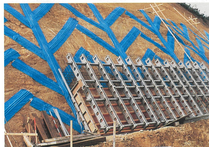
のり面排水および構造物裏込排水
