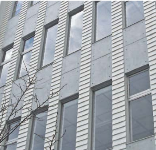
Product Data 所 在 地：東京都品川区 使用型枠：TSS-156、TSS-14
