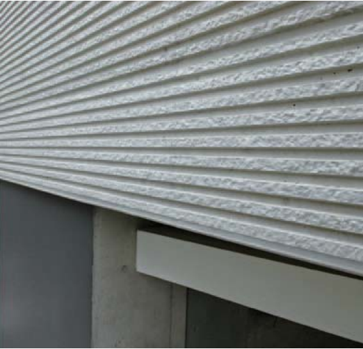
Product Data 所 在 地：東京都練馬区 使用型枠：TSS-73
