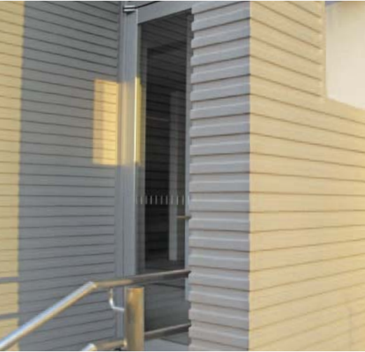
Product Data 所 在 地：東京都北区 使用型枠：TSS-422
