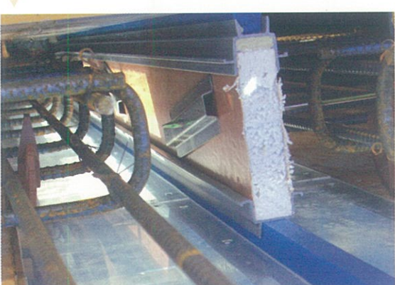
▲ 構造スリット型枠
