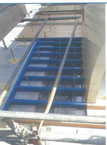
▲ 鋼製桁と下部工の ジョイント部の覆巻型枠
