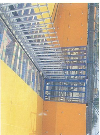
▲ 上部工工事 (壁式橋脚との取り合い部)
