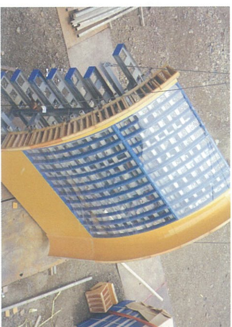
▲ 橋脚下部工(梁底アーチ部)
