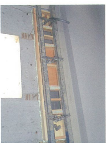
▲ 耐震補強工事・無収縮モルタル (グラウト材)の打設管理
