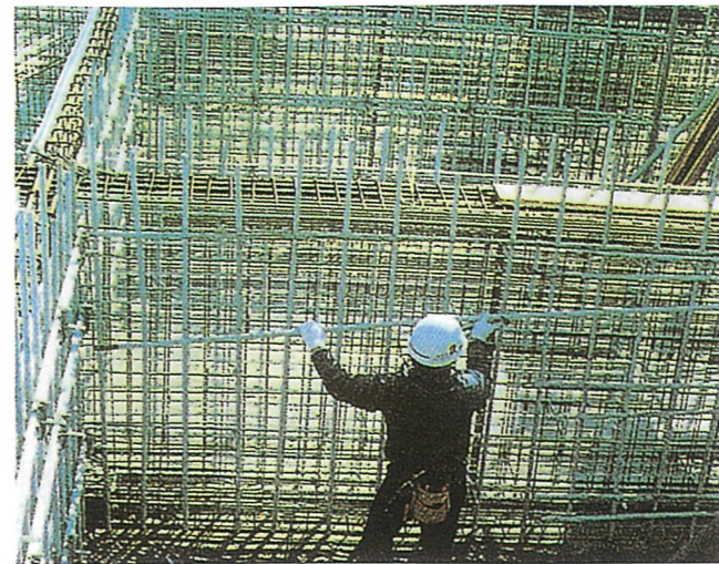
7 パイプの取付け 縦パイプの取付け間隔は、300mm以内で、結束線で仮止めします。
