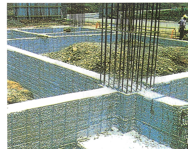
12 解体 フォームタイ、パイプ等の締付け金具を取りはずします。
