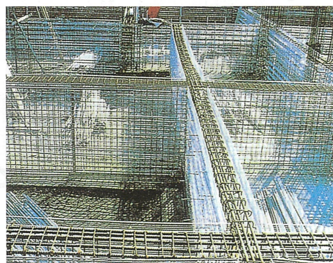
6 フォームネットの取付け フォームネットを両面に張り、フォームタイで締付けます。フォームネットのジョイントは、縦方向はリブとリブを重ね、横方向は100mm以上重ねて、結束線で結束します。
