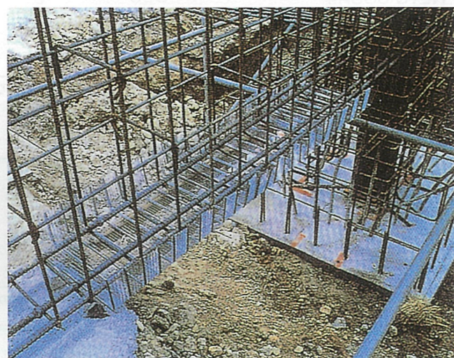
5 梁底の取付け 加工済のメッシュをスタラップ筋下端にワイヤーセパ(番線)にて仮止めします。
