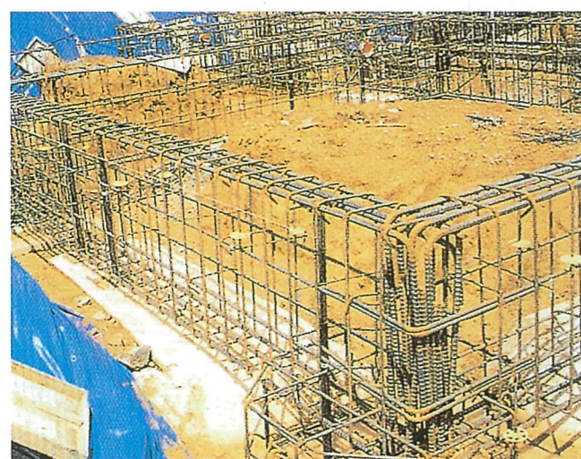
3 丸セパレーターの位置決め 丸セパレーターの取付場所に水系を張ります。
