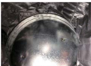
底鉄板の周囲を立ち上げることで、生地 の耐久性を確保
