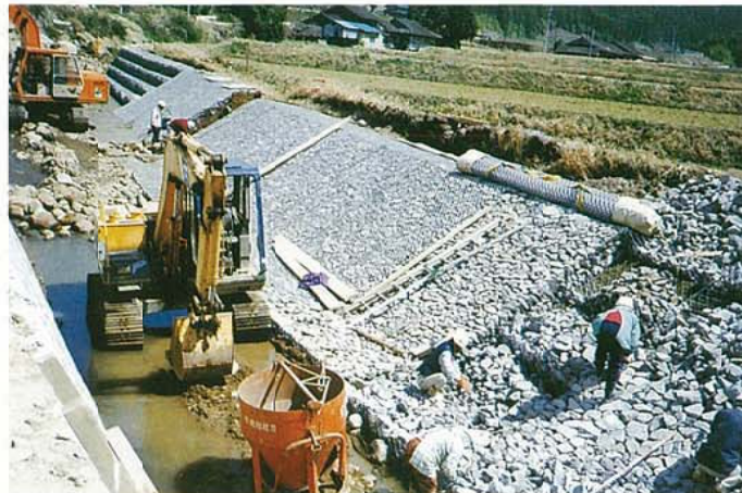
③ 護岸工かごマット 詰石状況
