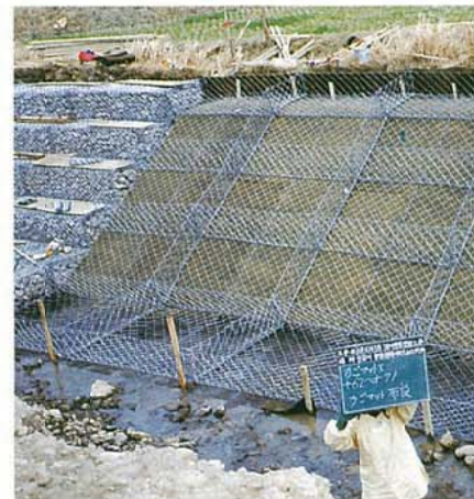
② 護岸工かごマット 布設
