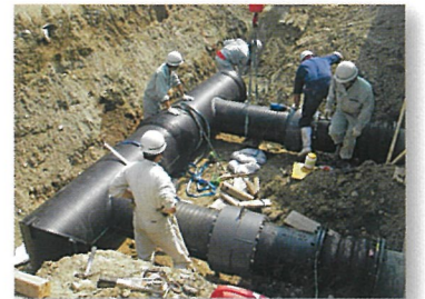
特殊ジョイントでの接続加工
