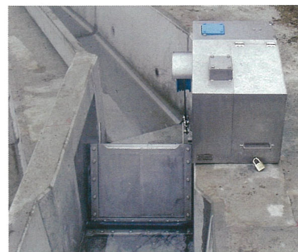
日田市役所/北向東寺雨水幹線新設工事 800×400
