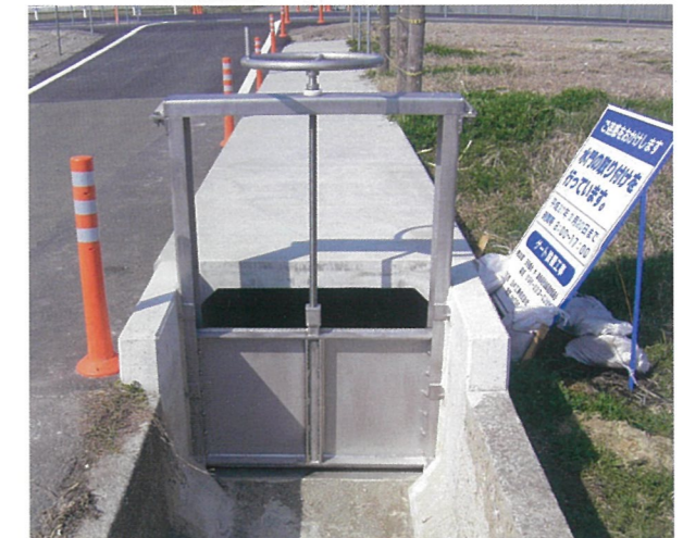
天明農地・水・環境保全組織運営委員会/護藤地区ゲート改修工事 980×700
