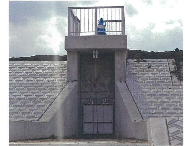
川内河川国道事務所/金波田築堤工事 巻上式1000×1000
