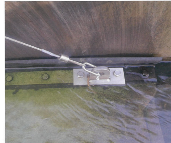
既設プレート接続部
