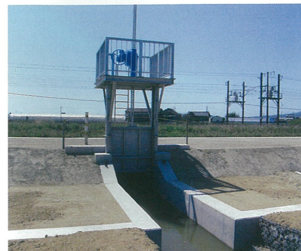
宇城地域振興局/新耕地川単県自然債河川改良工事 1400×1400
