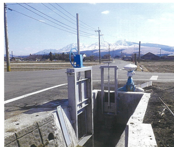
阿蘇地域農地・水・環境保全会 資源向上長寿命化工事(狩尾地区) 750×650
