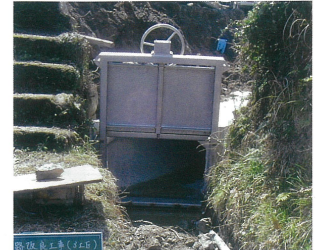
朝倉土木事務所/道路改良工事(3工区) 1000×600
