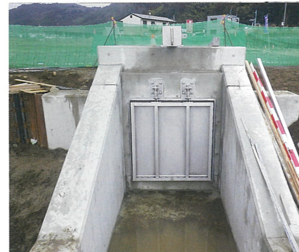
九州地方整備局筑後川河川事務所 花月川財津排水樋管新設築堤護岸工事 1200×1200
