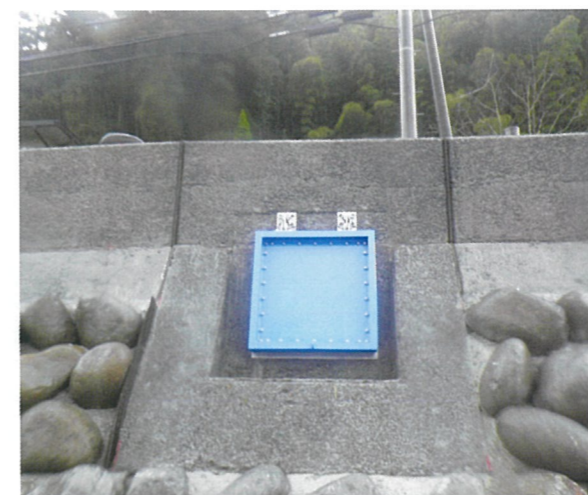
九州地方整備局筑後川河川事務所 花月川藤川地区築堤護岸工事 600×600
