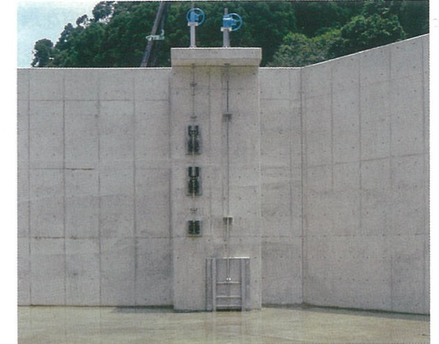
九州新幹線建設局／九幹鹿、三池T工事 土砂吐 600 取水φ150×3
