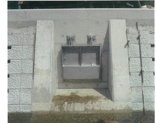
南薩地域振興局/長里工区防災工事 600×600
