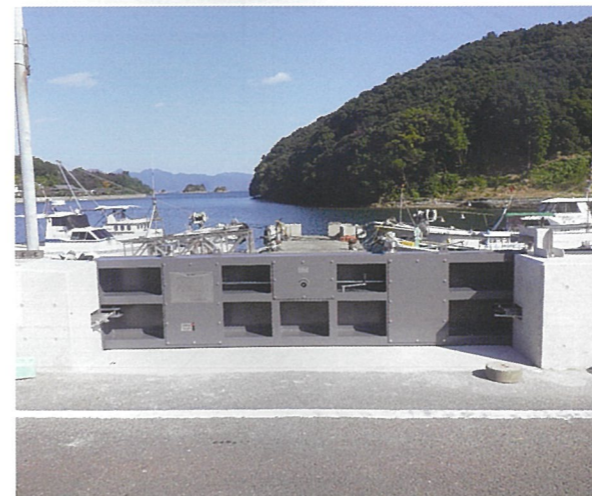
長崎県北振興局港湾漁港第一課 大瀬戸地区海岸開口部対策工事(1工区) 引戸式4000×900
