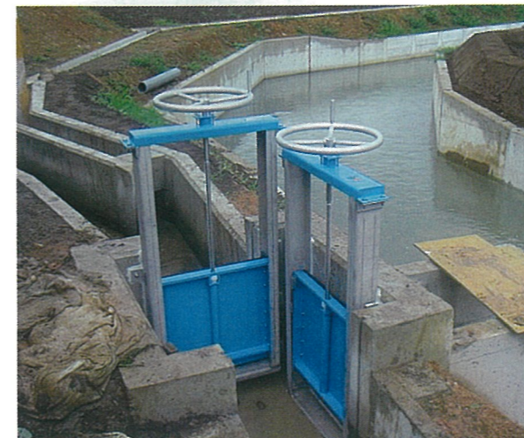
行橋土木事務所/支線12号用水路ゲート工事 600×600
