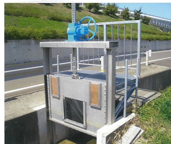
中津土木事務所/道路改良工事 1510×1000
