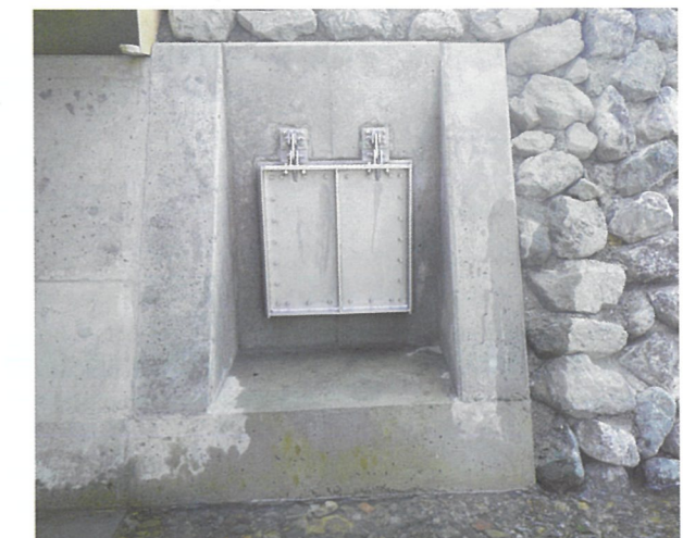
球磨村役場・平成29年度峯川河川整備工事 600×600
