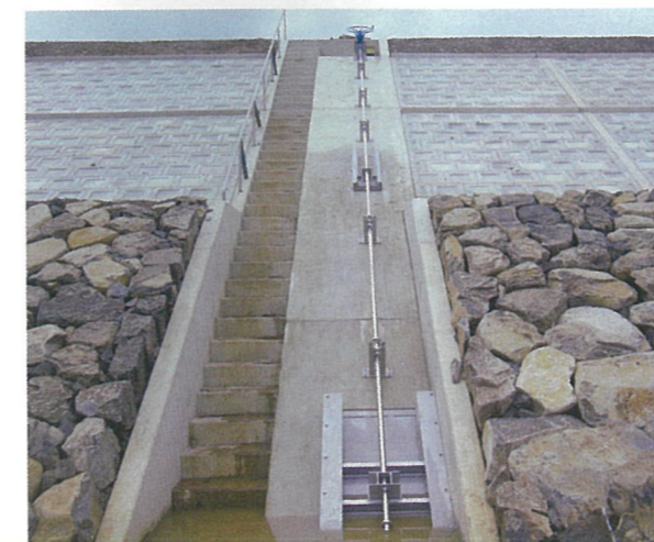
長崎県北振興局／渋柿地区ため池工事 土砂吐700、緊急放流300
