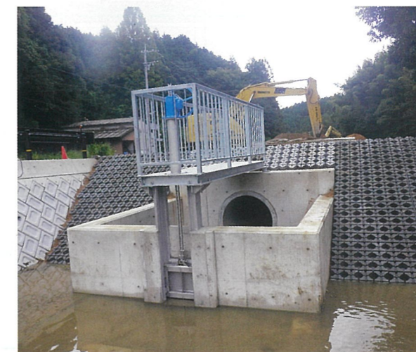
川崎町役場建設課 原屋敷線整備工事(2工区)450×450 操作台・防護柵
