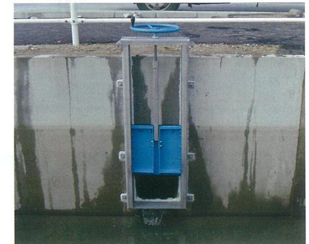
直方県道整備事務所/直方鞍手線道路新設工事 450×450
