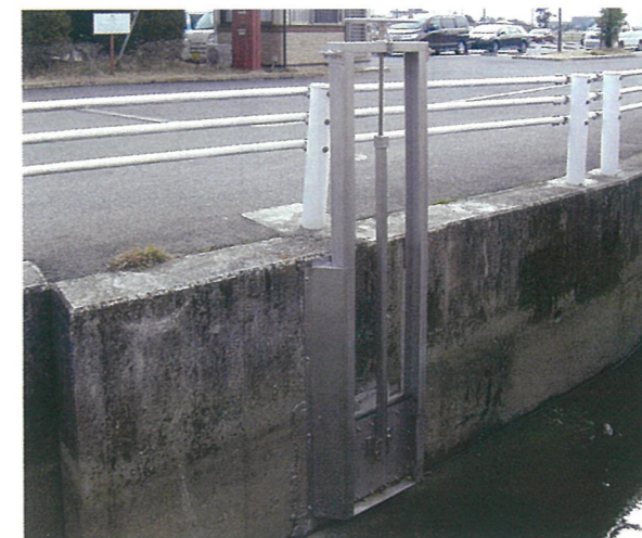
渡鹿堰土地改良区/所島地区ゲート取換工事 400×400
