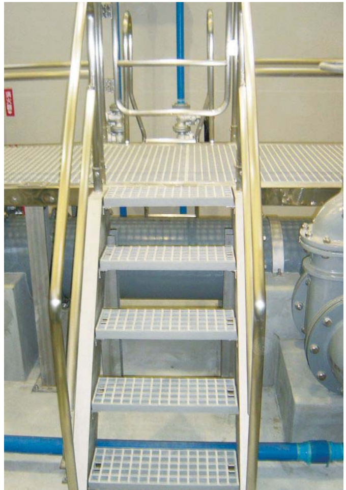
階段踏板施工例
