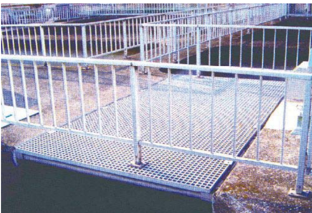
処理槽上歩橋施工例
