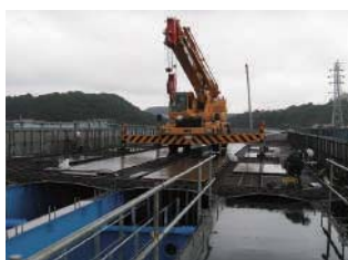
架設重機の上載
