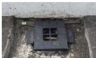
中心タイプ・舗装施工前
