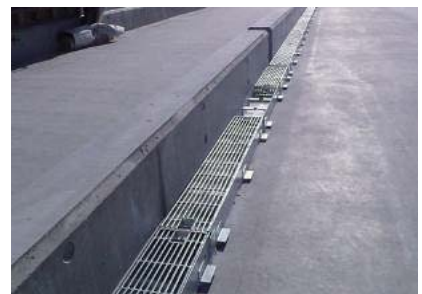
歩車道境界部
