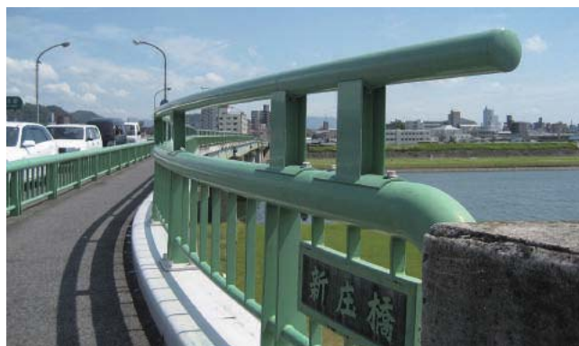
嵩上げ高欄(既設:鋼製高欄)
