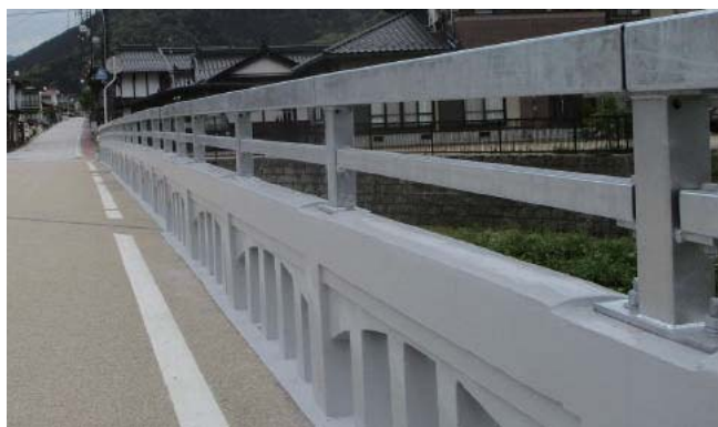
嵩上げ高欄(既設:コンクリート製高欄)
