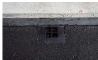
偏心タイプ・舗装施工後
