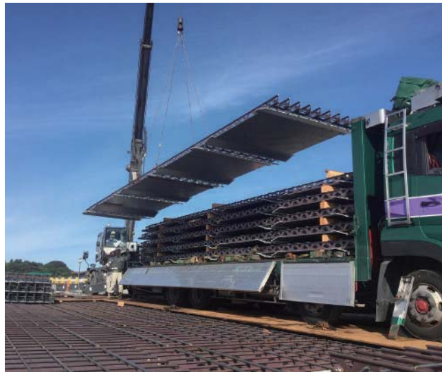
重機載荷し架設
