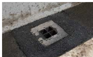
中心タイプ・舗装施工後
