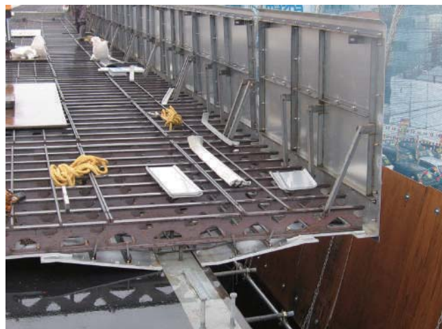
ハンチ部・壁高欄型枠
