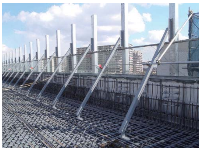
投物防止柵取付
