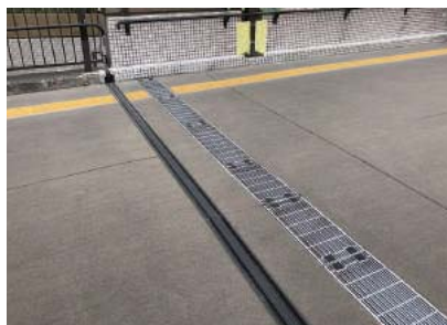
歩道橋・横断方向
