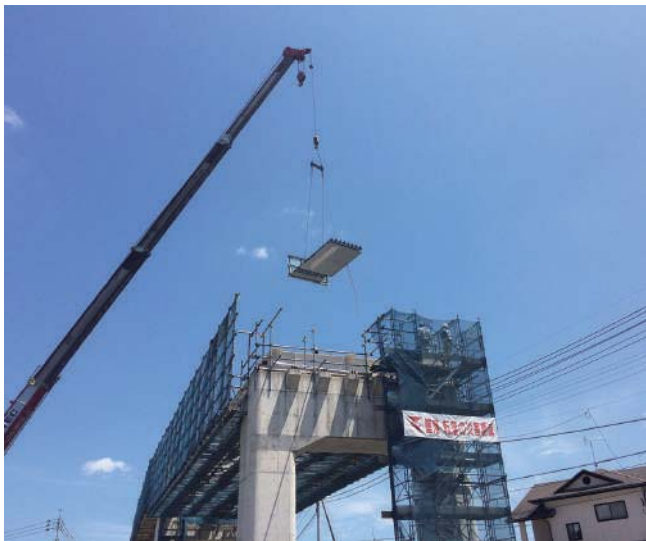
橋外から架設
