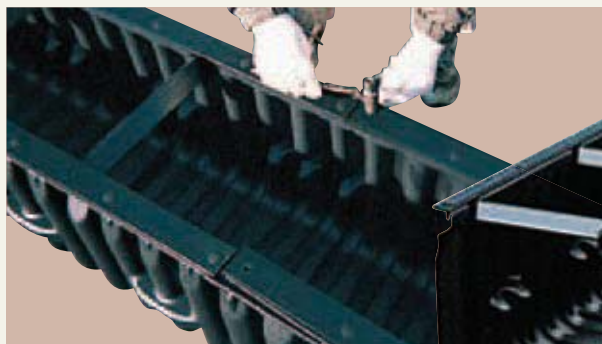
⑤重ね合せ部をボルトで 締付ける
