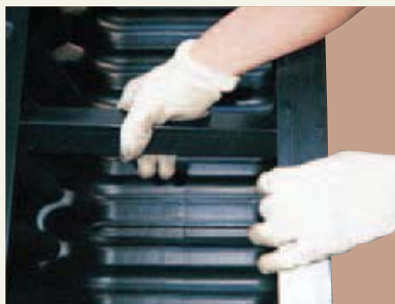
④突きあてアングルの取付け (下から斜に上げて取付けてください)
