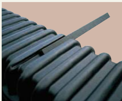
②浮上防止アングルの差込み
