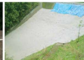
道路のり面保護
