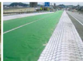
道路のり面保護
