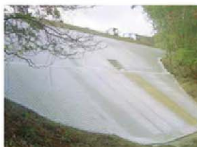
ため池 調整池工
