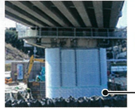
耐震補強・コンクリート巻き立て工
