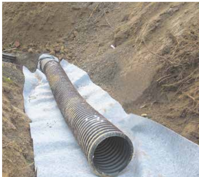
▲配水管回りにキュアマットCCタイプを使用
