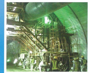
トンネル壁面
