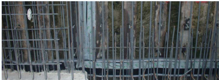
RGS交差部取付状況
