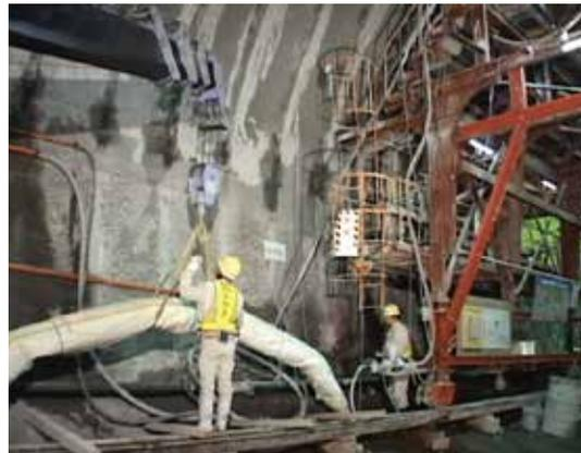
次シート防水材をシート型枠台車に広げた後、ラップ側の防水シート端部を20~30cm 折り返し、ラップ側不織布に穴を開け、注入口を設置する。
