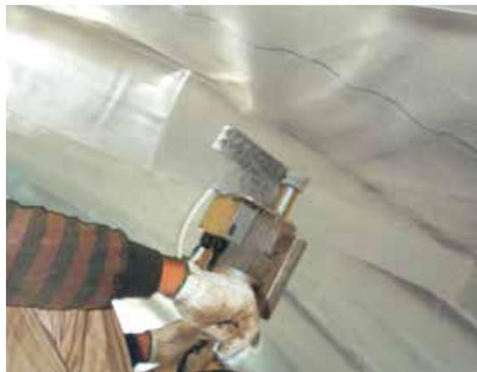
拌み合わせ溶着部を倒し手動式熱風溶着機を用いて溶着する。
