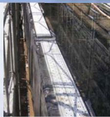
足場用踏み板で固定
