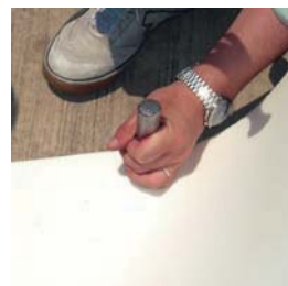
ポンチにて穴開け加工
