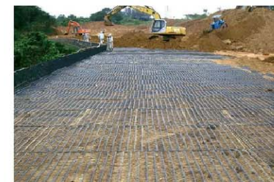
アデム敷設状況
