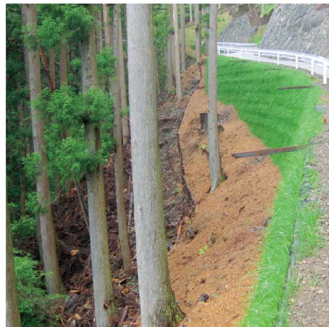
林道工事事例 ・壁面の高さ(m):4.2 ・壁面の勾配:2分
