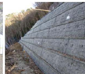
林道工事事例 ・壁面の高さ(m):4.2 ・壁面の勾配:2分
