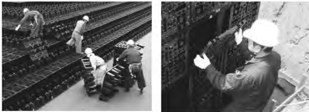
組立て作業の様子
