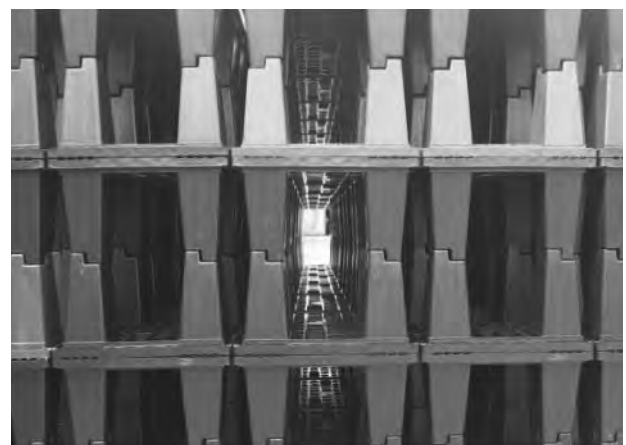
広いトンネル構造
