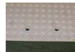
貫通孔の施工例
