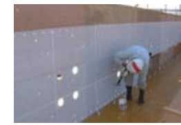
型枠への貼りつけ
