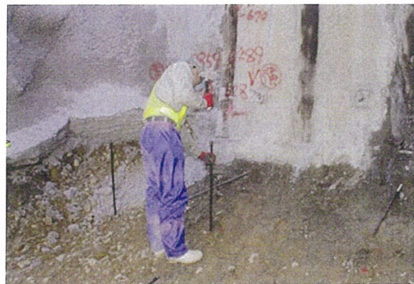
ボルト打込み
