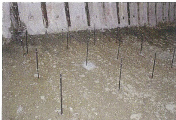
PT-ANCHOR 建込み完了
