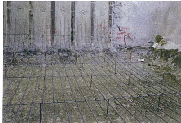
鉄筋組立状況
