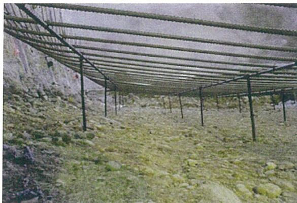
鉄筋組立状況
