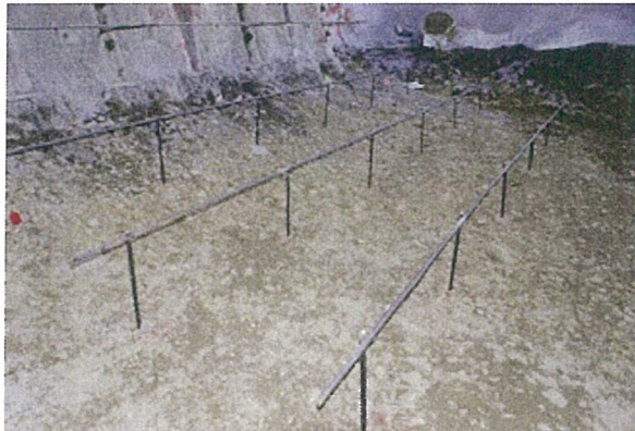
段取り筋 設置完了
