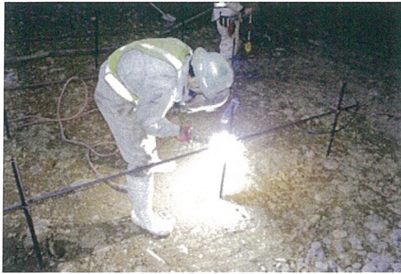
段取り筋 溶接
