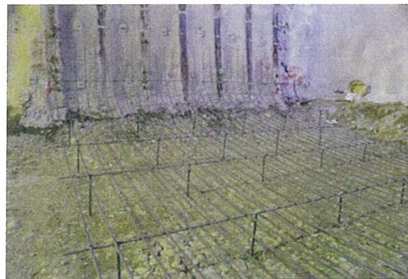
鉄筋組立状況
