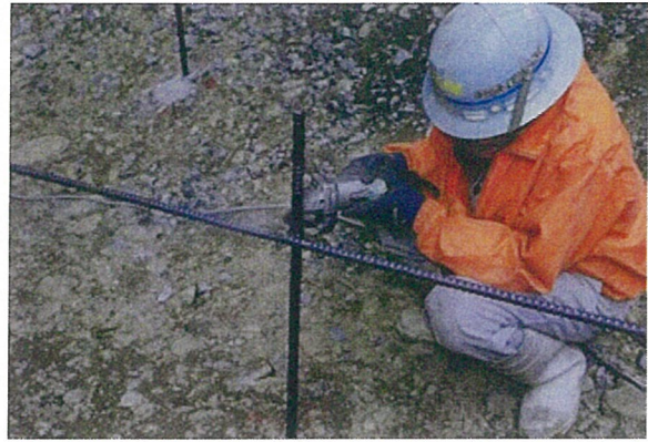
GFRP ボルト頭部処理
